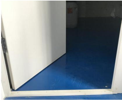
门口隔挡措施
